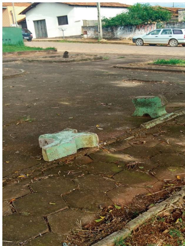
Figura 5. Praça Dr. Hermírio, com banco quebrado e destruição da calçada
